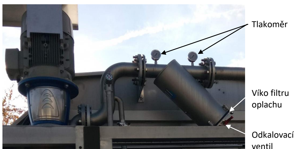
Obr. 60 Filtr oplachu typu B
