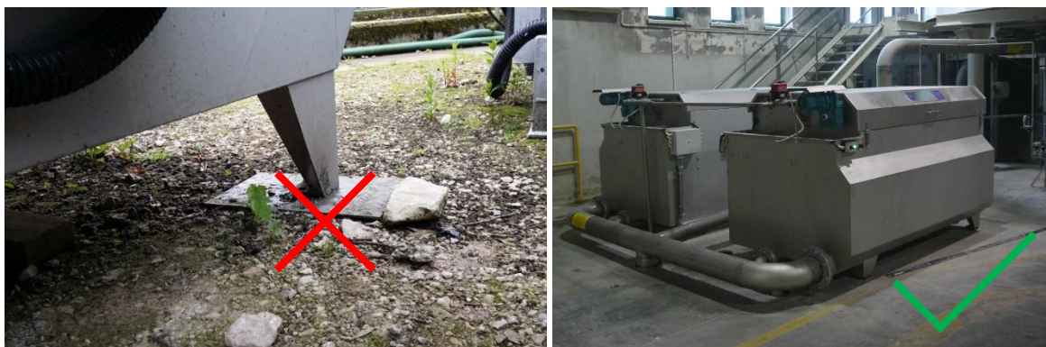
Obr. 33 Nevhodná a vhodná instalace filtru
