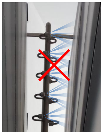
Obr. 47 Špatný proud z trysek (zobrazeno pouze jedno sprchovadlo)
