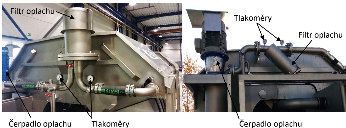
Obr. 9 Filtr oplachu (typ A a B – dle kapacity filtru)
