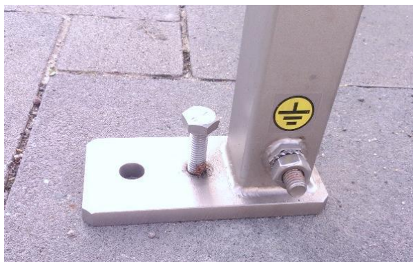
Obr. 22 Hlavní zemnicí bod
