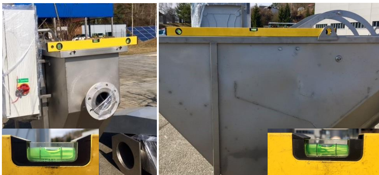
Obr. 19 Kontrola vodorovné polohy zařízení (z čela, z boku)
