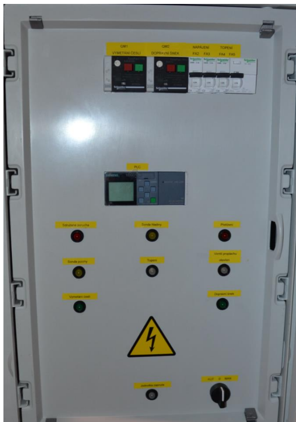
Obr. 27 Rozvaděč MZ se zateplením
