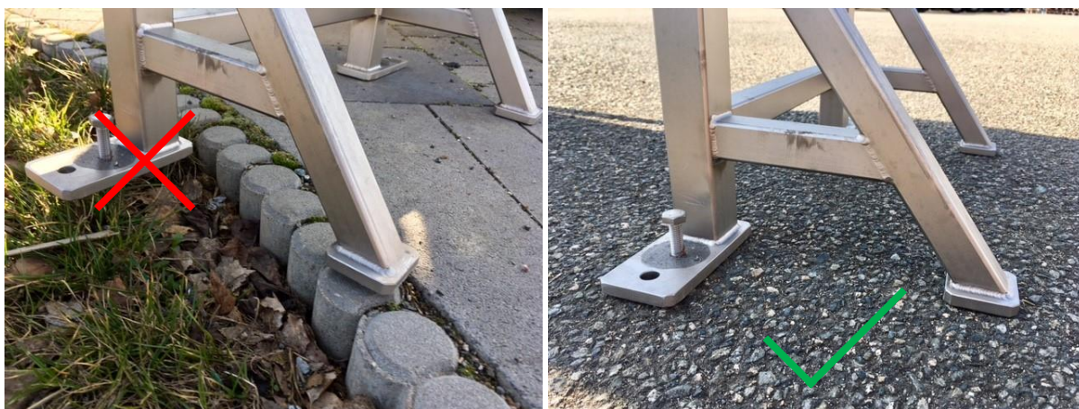
Obr. 21 Nevhodná a vhodná instalace zařízení
