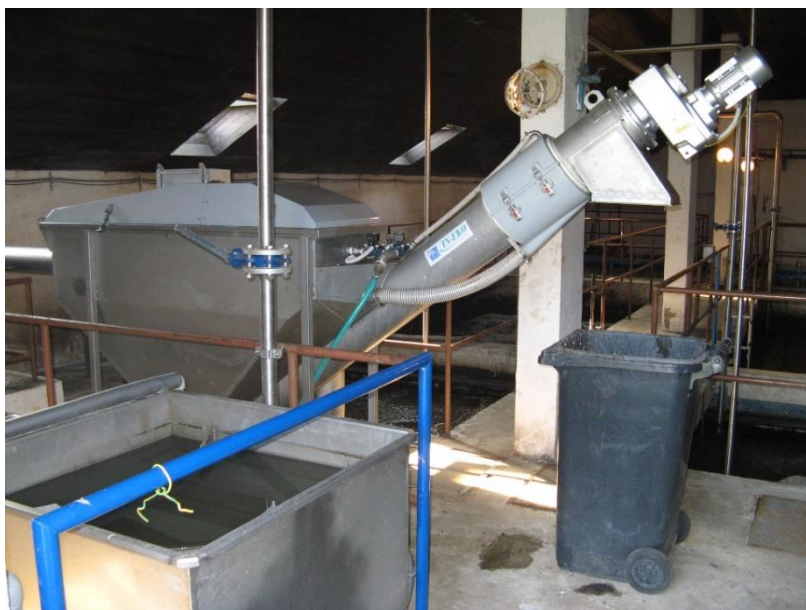
Obr. 8 MZ s odvodněním shrabků
