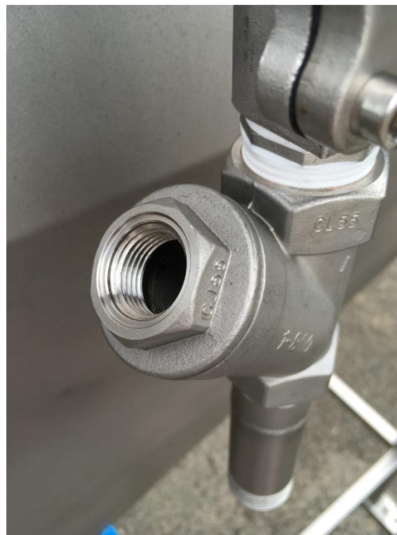
Obr. 34 Čištění filtru do potrubí
