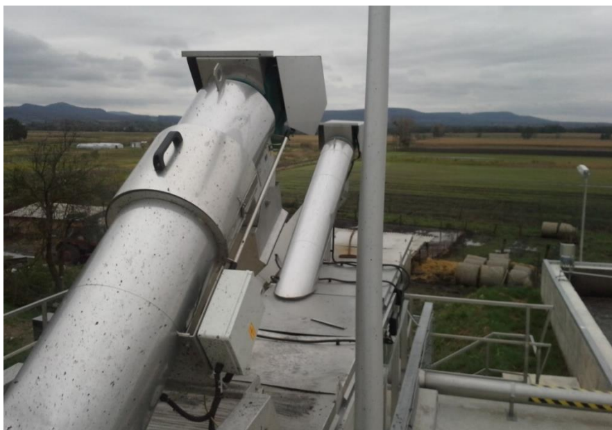
Obr. 10 MZG_CSP s odvodněním shrabků
