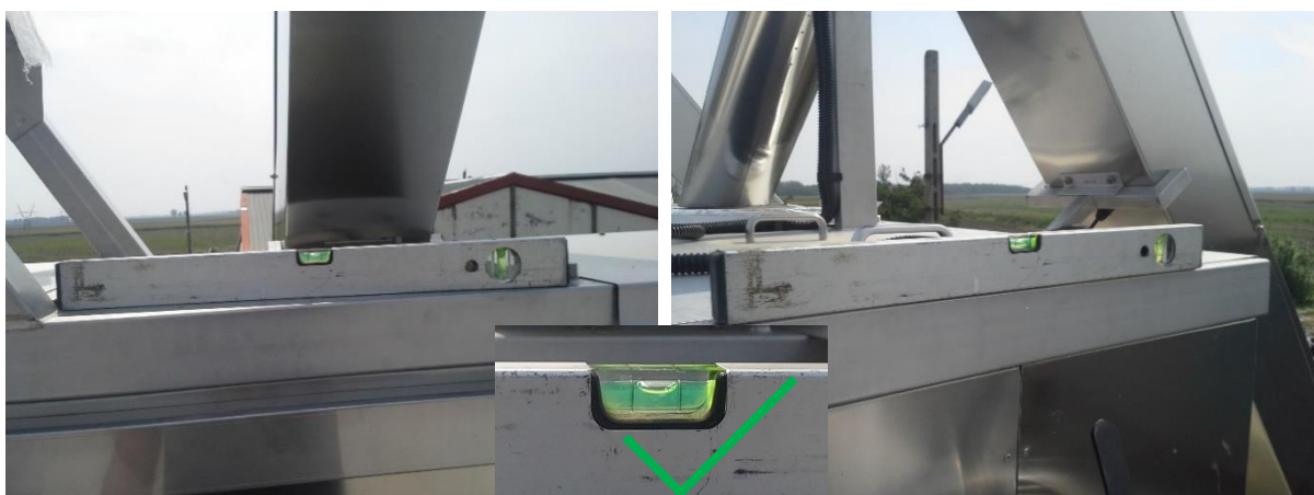
Obr. 27 Kontrola vodorovné polohy zařízení (z čela, z boku)
