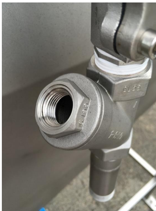
Obr. 45 Čištění filtru do potrubí
