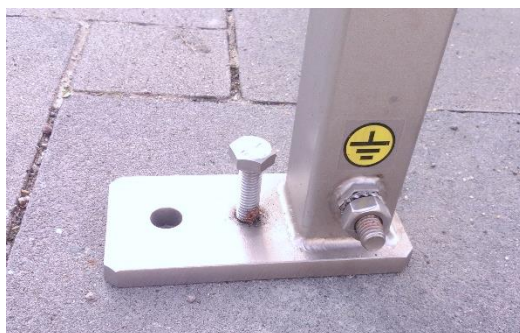
Obr. 31 Hlavní zemní bod
