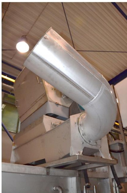
Obr. 12 MZG_CP s lisem pro odvodnění shrabků
