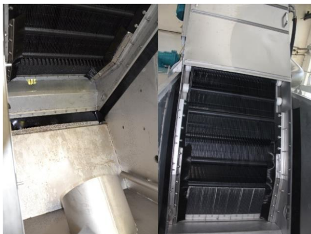
Obr. 5 Detail česlí MZG_CP
