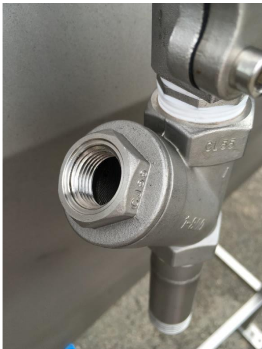
Obr. 36 Čištění filtru do potrubí
