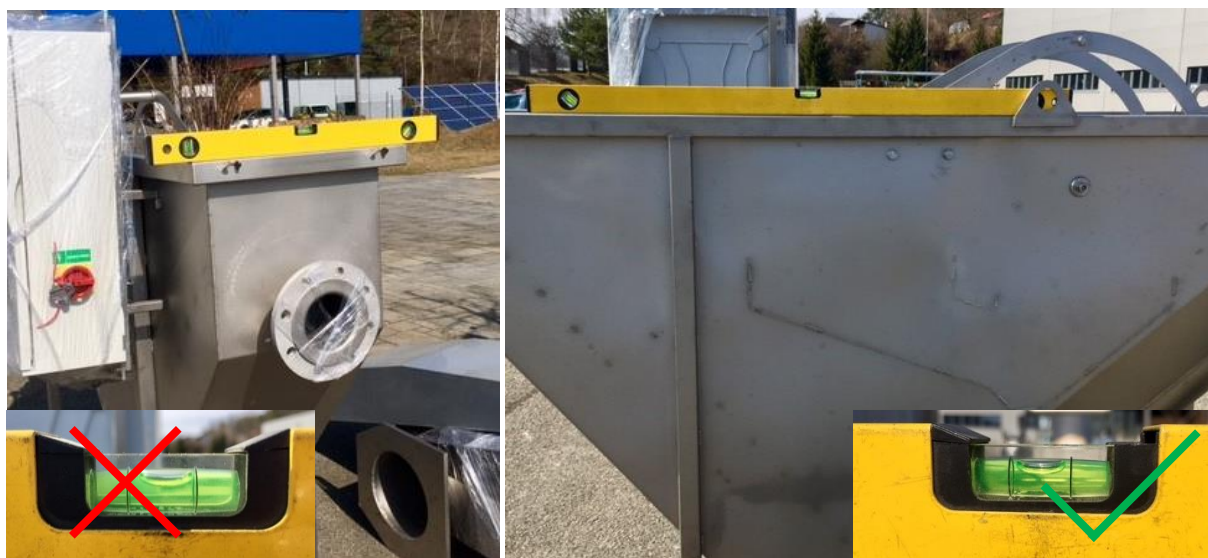
Obr. 22 Kontrola vodorovné polohy zařízení (z čela, z boku)
