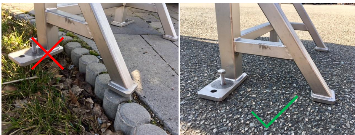
Obr. 24 Nevhodná a vhodná instalace zařízení
